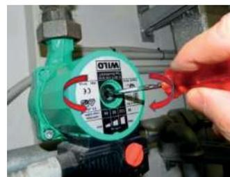
*Ensuite, avec le petit, on bouge de droite à gauche, le rotor du circulateur, qui agit sur l'entaille accessible sous le couvercle enlevé.*
